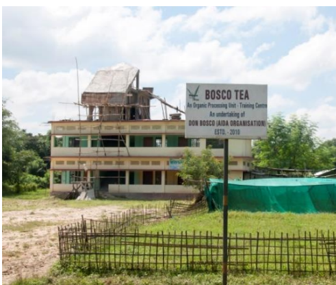
Das Trainingszentrum war im August 2014 so gut wie fertiggestellt. Jetzt wird noch die Terrasse ausgebaut.
