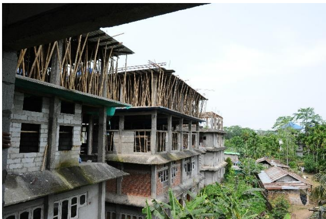
Das obere Stockwerk ist bereits erkennbar.
