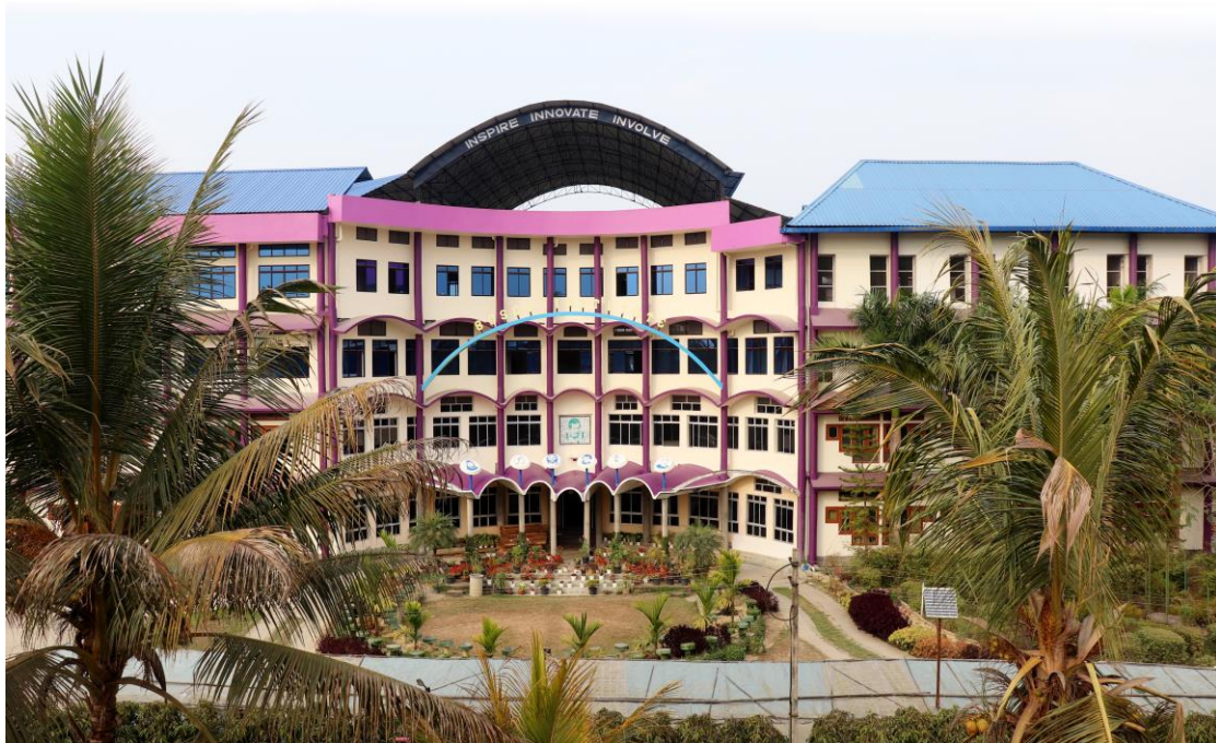
Das fertiggestellte Gebäude des Innovation Hub (Jorhat, Mai 2021)
