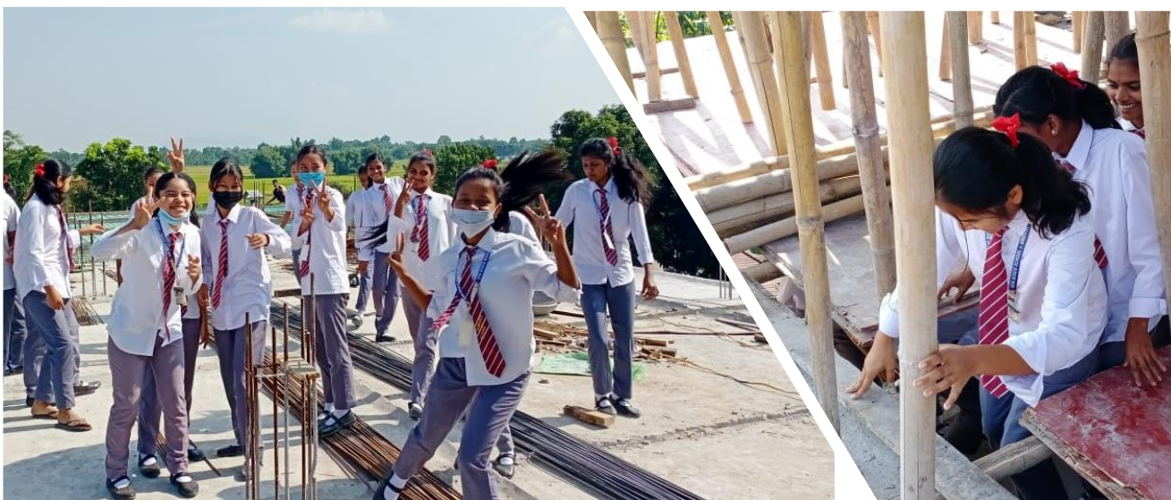
Schülerinnen der Klasse 8 inspizieren die Baustelle des Neubaus (Amguri, November 2021)
